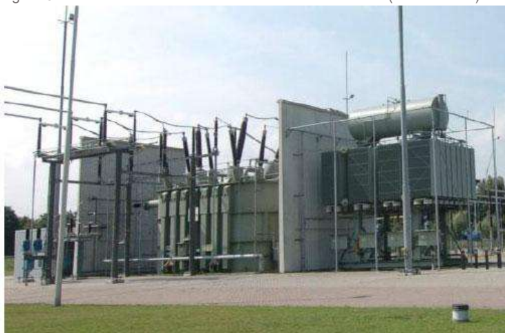
Figuur 5.2 Voorbeeld transformator in een transformatorcel (scherfmuren)
